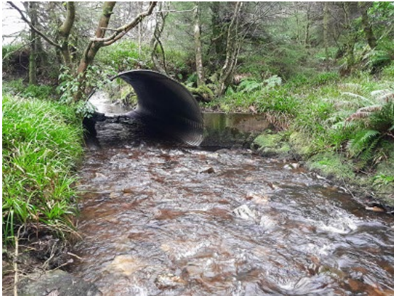
Fig. 3.1.3.1 Culvert obstacle RB01-01
